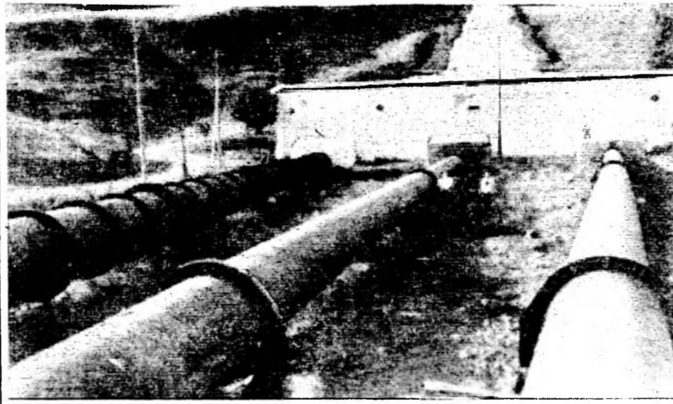
На снимках: сверху — по этим трубопроводам восьмой насосной станции вода поднимается до 20 метров вверх;
