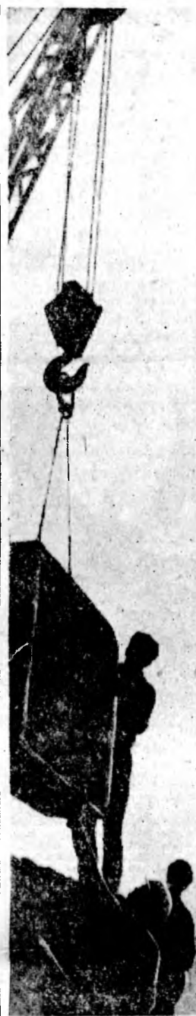
В колхозе «Большевик» полным ходом идет строительство животноводческих помещений. Два из них сооружаются из крупных блоков. Это значительно ускоряет время работ.
