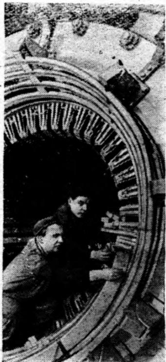
На ленинградской фирме «Электросила» подходят к концу работы по изготовлению турбогенератора-исполни мощностью в один миллион киловатт. Нигде в мире такой машины нет. Только стальная конструкция ротора без обмотки весит около 80 тонн. При работе он будет вращаться со скоростью три тысячи оборотов в минуту.
